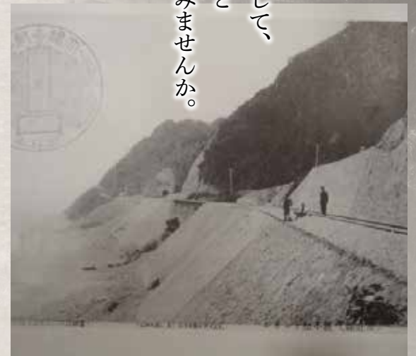
奥に見えるのが「親不知レンガトンネル（西側坑口）」（大正初め頃）
